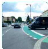
► Une bande cyclable est une voie contiguë à la chaussée, réservée aux cyclistes. Elle est délimitée par des bandes blanches peintes au sol. Cette signalisation pouvant être complétée par des pictogrammes « vélo » et des flèches indiquant le sens de circulation. Une bande cyclable fait partie intégrante de la voie à laquelle elle est accolée. Elle constitue simplement une file de circulation supplémentaire.
