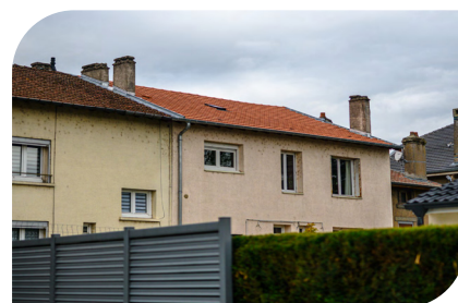
Frouard - Réfection de la toiture
