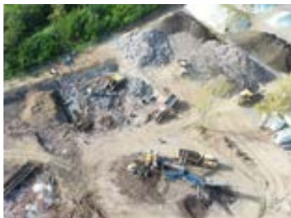
Terrassement et criblage des déblais avec mise en stock par lot sur plateforme, démolition des infrastructures et des laitiers
