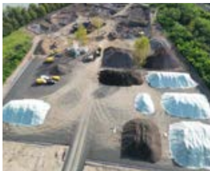
Préparation de la construction du pôle aquatique, 1 er équipement de l’Écoquartier
