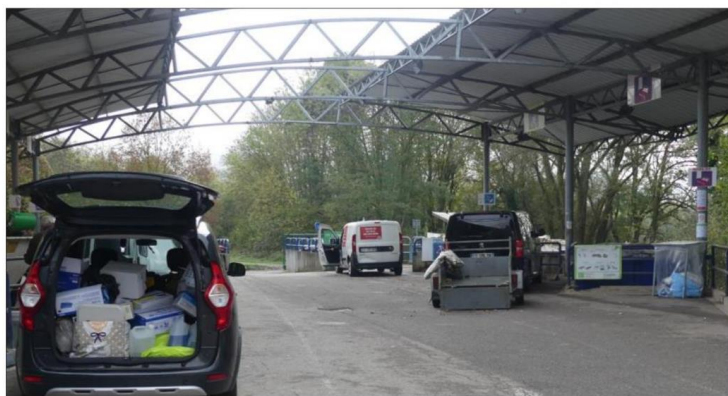
La déchetterie de Frouard arrive à saturation. Un chantier d'extension va démarrer en septembre.
