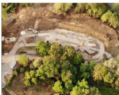
Il ne reste plus rien de l'ancien équipement de la déchetterie intercommunale de Frouard.
