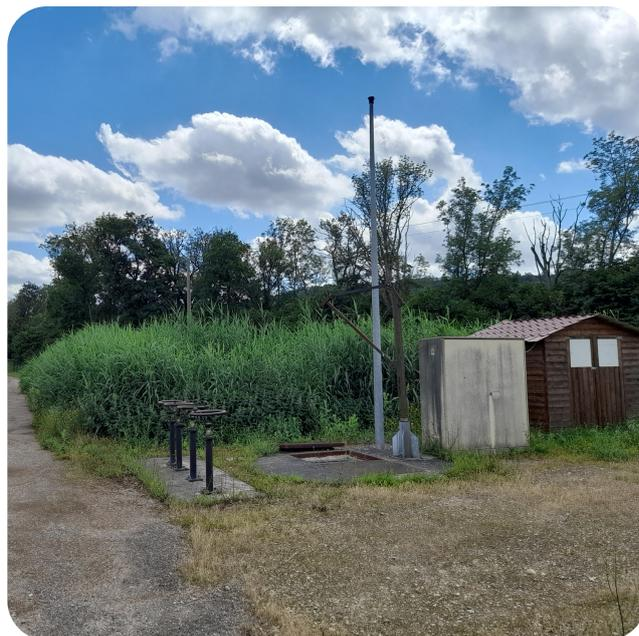
La station fonctionne à lits plantés de roseaux, et reçoit les effluents des communes de Malleloy et de Faulx.
